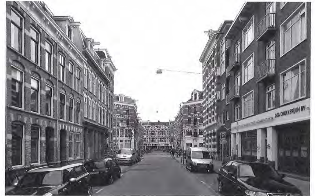
De Swammerdamstraat gezien naar de Ruyschstraat en Blasiusstraat, met deels nog de oorspronkelijke laat-negentiende-eeuwse bebouwing, 2008
